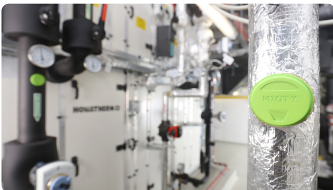
mioty ist eine der ersten Funkkommunikationslösungen für IIoT-Anwendungen basierend auf dem ETSI Standard TS 103357. (Bild: Fraunhofer IIS / Kurt Fuchs)
